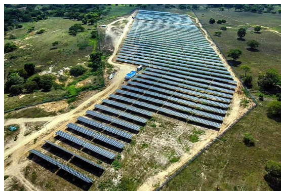
Fig. 1 Parque Solar Canal del Dique 10 MWp.
