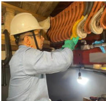
Figura 5. Bobinas reparadas, lado superior (arriba) y lado inferior (abajo)
