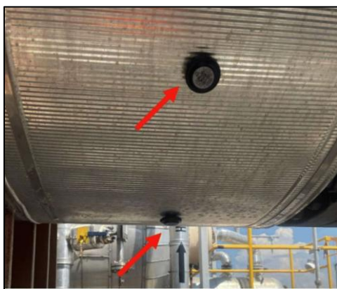
Fig. 4. Instalación Sensores.
