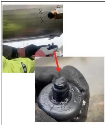
Fig. 8. Evidencia de humedad detectada por sensor.
