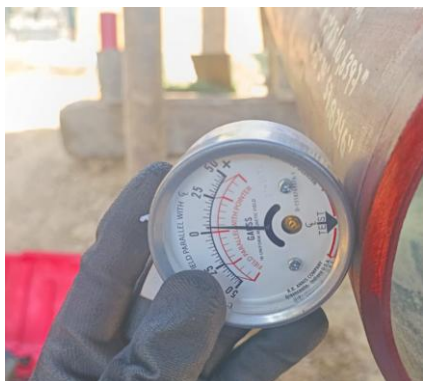
Imagen 6. Medición Final del Campo Magnético en la tubería
