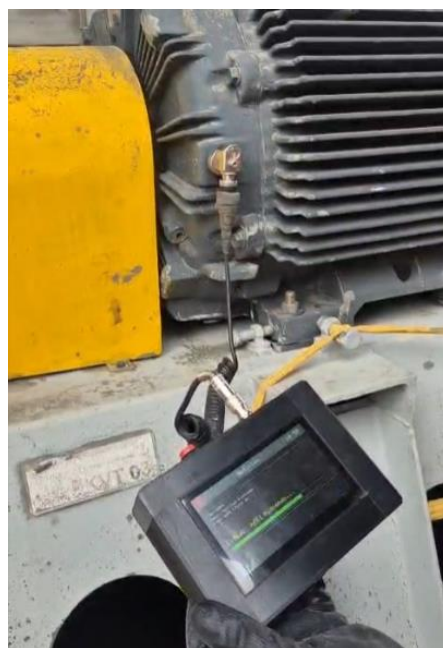
Fig. 8 Medición de equipos
