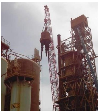
Ilustración 3 Izaje conjunto cap + ciclones Reactor R2701, 2014.
