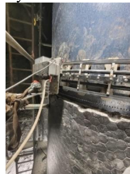
Ilustración 28 hidro corte riser interno.
