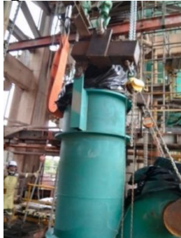
Ilustración 25 "Bull rigging" Wye Section.
