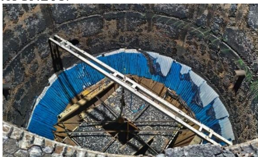
Ilustración 30 "Stack Cleaner" instalado dentro del Reactor R4201.
