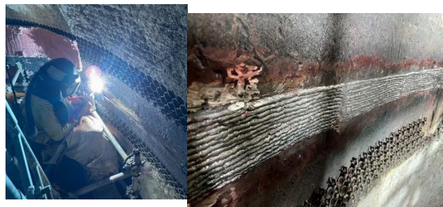
Ilustración 46 Soldadura Cap.
