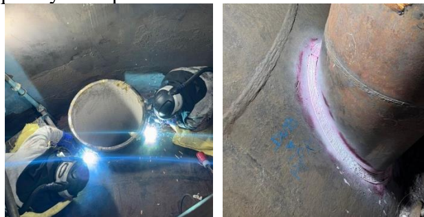
Ilustración 42 Soldadura ductos ascendentes.
