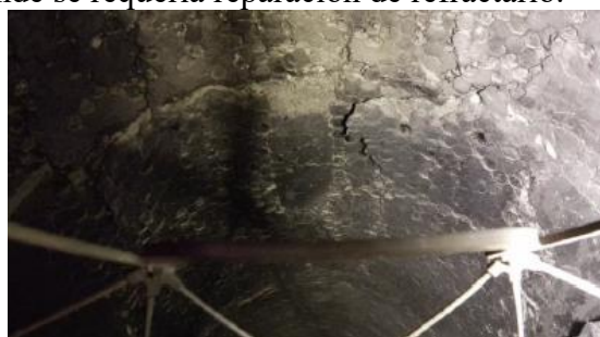
Ilustración 38 Imagen del Dron Elios II dentro del riser interno.
