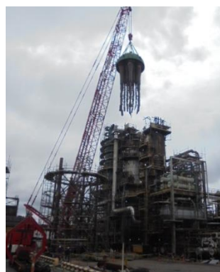
Ilustración 4 Izaje cap + ciclones Regenerador R302, 2016.
