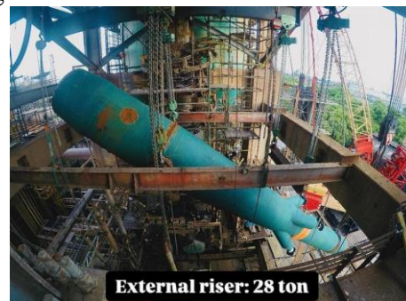
Ilustración 24 "bull rigging" riser externo
