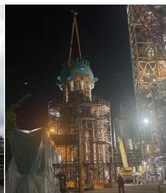
Ilustración 5 Izaje cap + ciclones Regenerador R2702, 2022.
