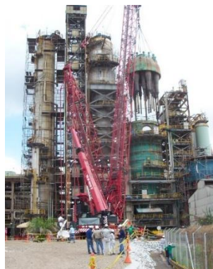
Ilustración 2 Izaje conjunto cap + ciclones Regenerador R4202, 2011.
