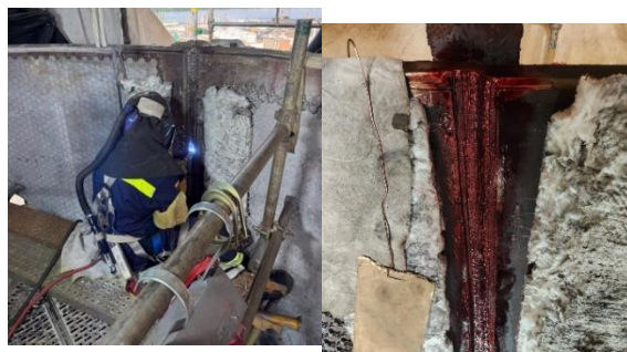
Ilustración 45 Soldadura Insert Plate.
