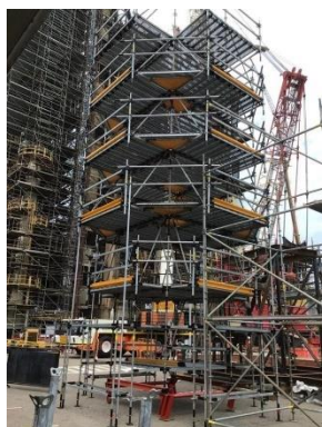
Ilustración 34 Preensamble en piso andamio PERI-UP.
