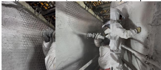
Ilustración 41 Aplicación de antierosivo RMax-MP mediante método lanzado.
