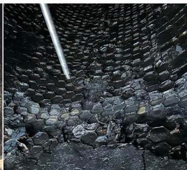
Ilustración 32 Hidro demolición refractario riser interno.
