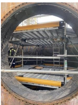
Ilustración 36 Andamio PERI-UP dentro del reactor R4201.
