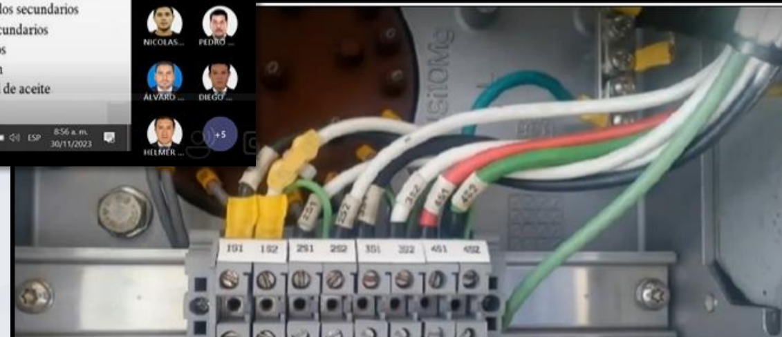
Caja de conexiones secundarias típicas de un transformador de corriente tipo ABB IMB 123/245/550
