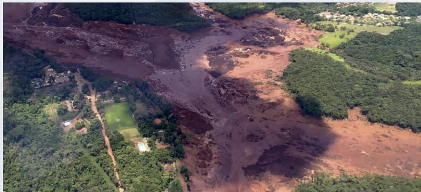
Presa de Brumandinho (Brasil) (2019) – 322 muertes - Fallo estructural relleno presa
