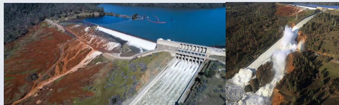
Oroville Dam(2019) (EEUU) – 200,000 Evacuaciones Aumento de lluvias – rotura del vertedero
