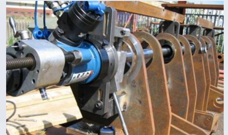
REACONDICIONAMIENTO EN SITIO
